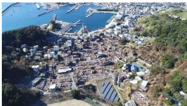
写真2-3-1 被災後の空中写真
