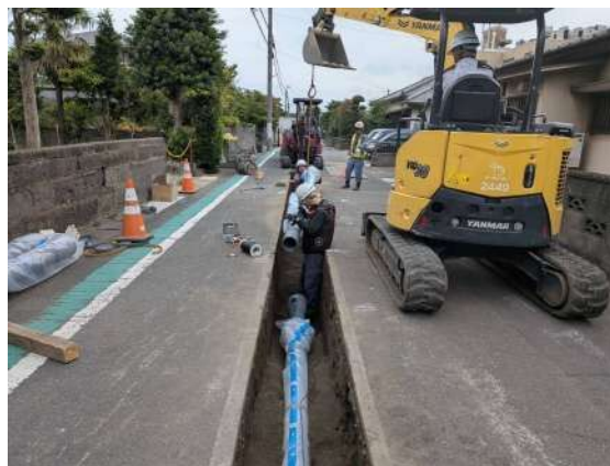
写真3-3-1 上水道の更新イメージ
