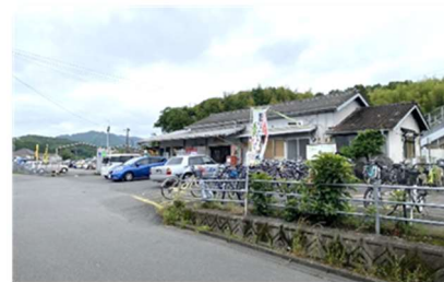
中判田駅周辺の現況
