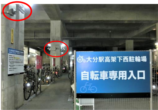
防犯カメラ設置状況（大分駅高架下西駐輪場）
