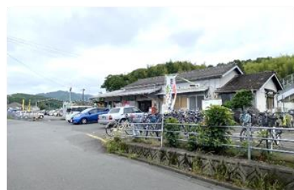
中判田駅周辺の現況
