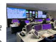
【消防通信指令センター】
