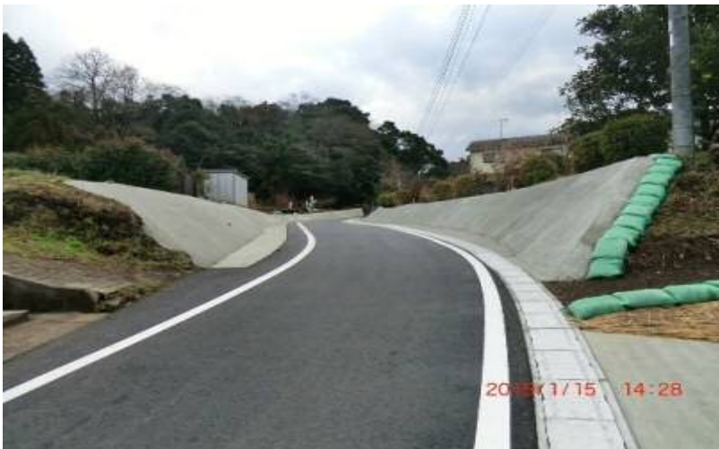
市道牟田権現線 A路線 (張コンクリート)
