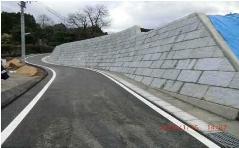
市道牟田権現線 A路線 (ブロック積み)
