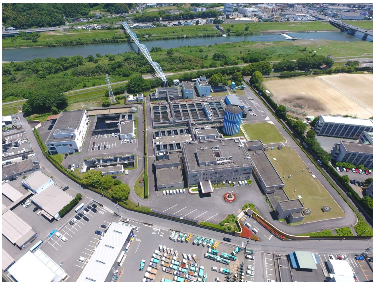
古国府浄水場 全景
