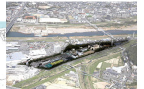
③ 松岡水資源再生センター
