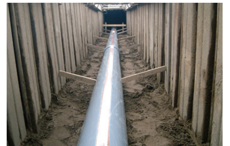
下水道管 (汚水管)
