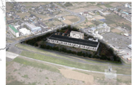
④ 原川水資源再生センター
