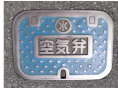
空気弁 (水道管の中の空気をぬく)
