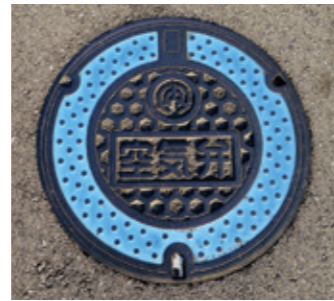
空気弁 (水道管の中の空気をぬく)
