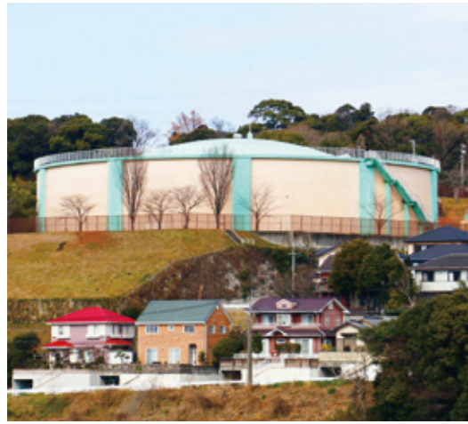
高台にある配水池
