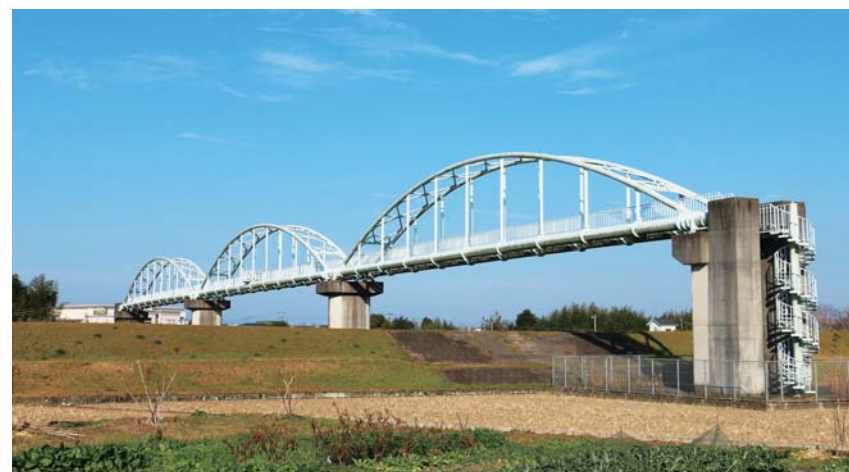
七瀬川水管橋 (平成8年完成)
