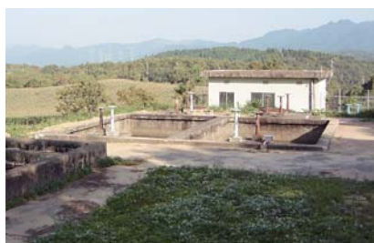
旧野津原西部第1浄水場
