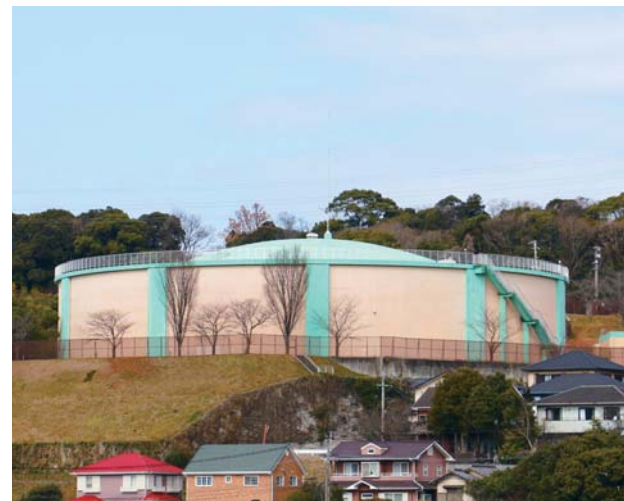
太平寺配水場 (平成8年完成)
