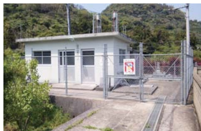
旧一尺屋浄水場
