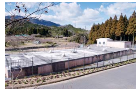
住床減圧水槽 (平成9年完成)
