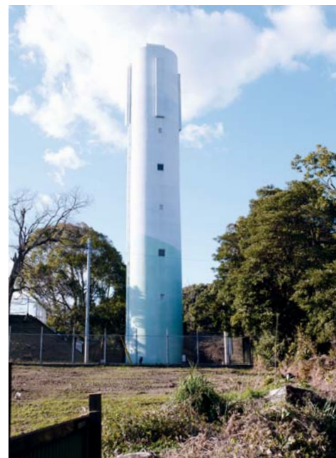
上野高架水槽 (平成10年完成)
