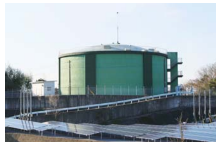
丹川配水池 (平成6年完成)
