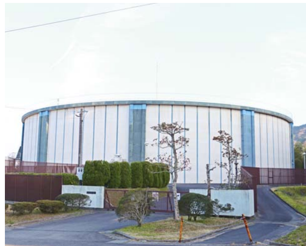
石川配水場 (平成4年完成)
