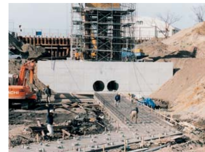
取水樋門築造工事 (昭和63年2月撮影)
