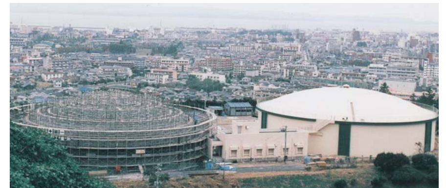
増量工事中の三芳配水場(昭和62年10月21日撮影)
