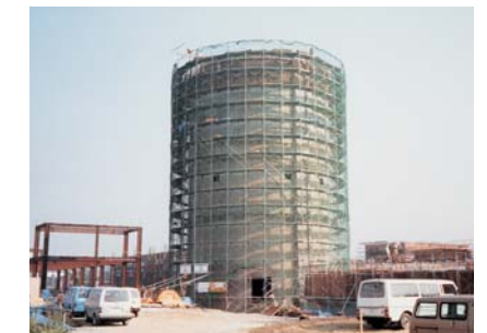
築造工事中の洗浄水槽
