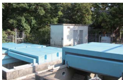
旧田ノ浦浄水場
