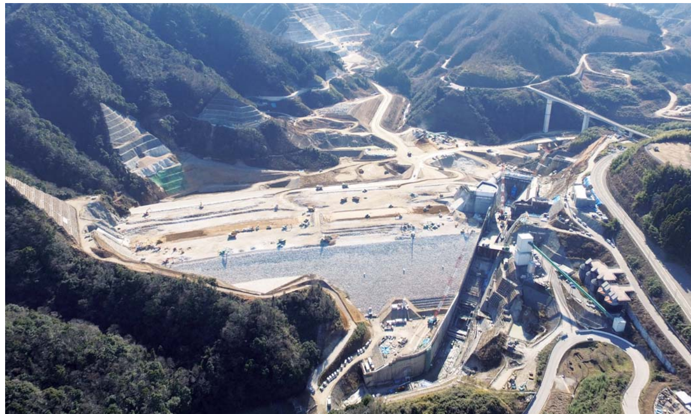
現在も築造工事中の大分川ダム（平成29年1月撮影）
