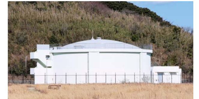
佐賀関配水池 (平成21年完成)
