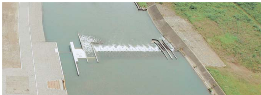
古国府浄水場取水施設 (平成21年撮影)
