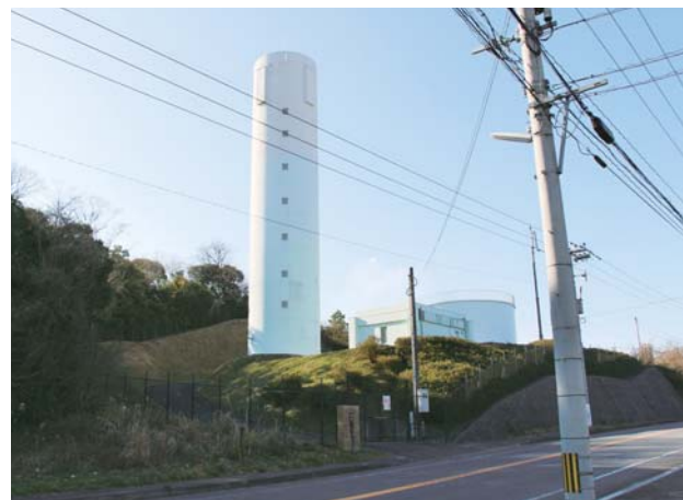
岡第2ポンプ所、岡配水池、岡高架水槽 (平成16年完成)
