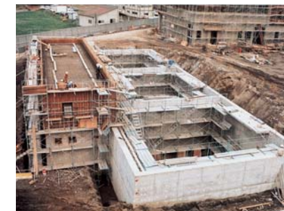
築造工事中の排水池
