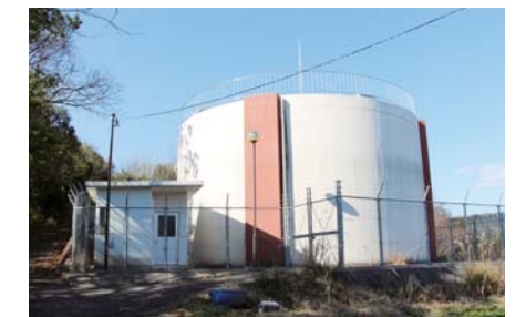
野津原東部配水池 (平成19年完成)
