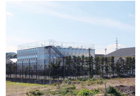
馬場ポンプ所 (平成23年完成)
