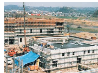
築造工事中の管理本部
