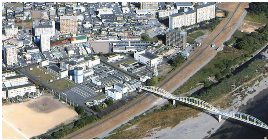
古国府浄水場と大分川水管橋
