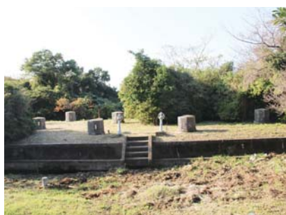
佐賀関地区廃止施設 旧田尻配水池
