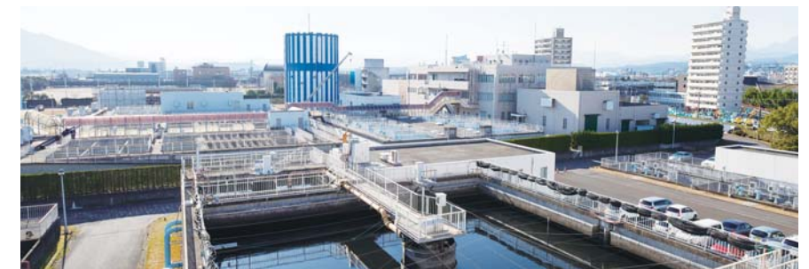
古国府浄水場全景 (平成28年撮影)
