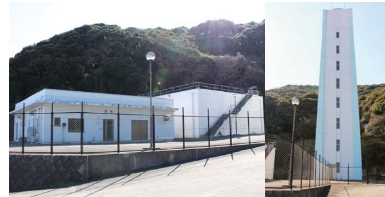
志生木ポンプ所・高架水槽 (平成23年完成)
