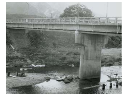
口径250mm鋼管添架工事の終了した田尻橋(七瀬川)(昭和43年11月撮影)
