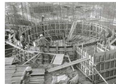
築造工事中の洗浄水槽 (昭和49年撮影)
