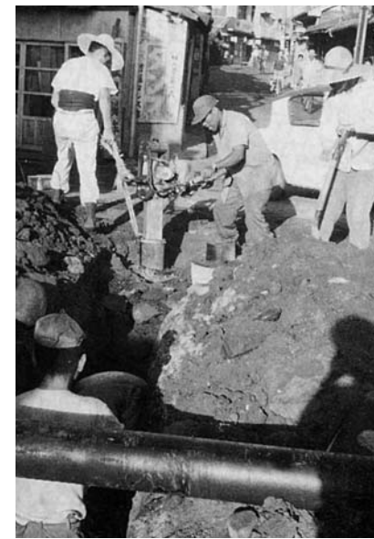
三ヶ田町配水管布設工事(昭和43年8月撮影)
