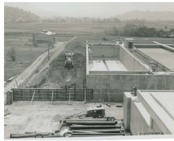
増設工事中の光吉浄水場薬品沈澱池(昭和42年撮影)
