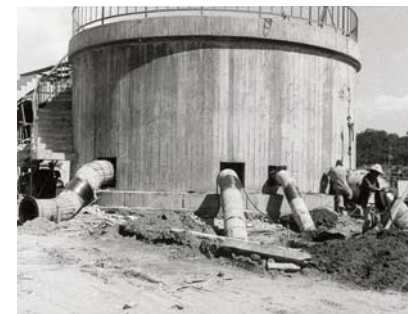
着水井まわり配管工事 (昭和43年撮影)
