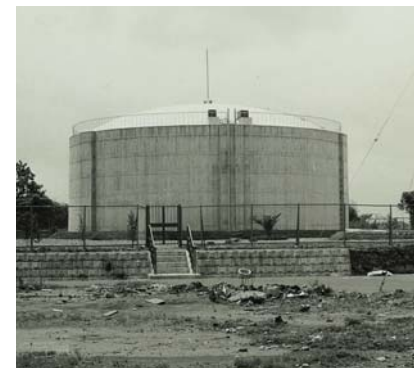
完成した明野配水池(昭和44年4月撮影)
