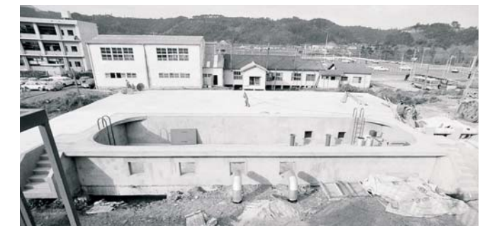
築造工事中の浄水池
