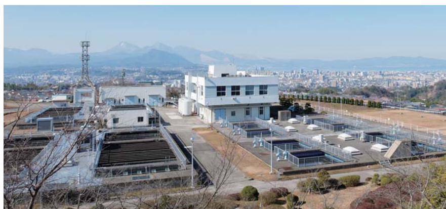
横尾浄水場全景 (平成28年撮影)
