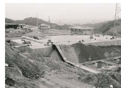
築造工事中の配水池 (昭和47年5月撮影)
