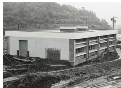
導水ポンプ室 (昭和47年6月撮影)
