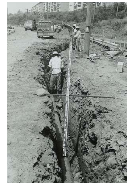
明野団地内の県道に布設中の口径250mm 鑄鉄管(昭和44年8月撮影)
