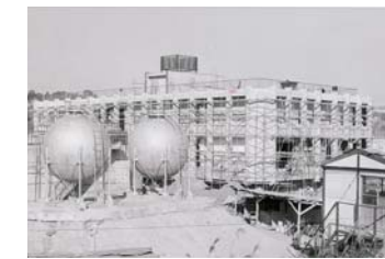
▲工事中の管理本館と硫酸バンド槽 (昭和43年3月撮影)
