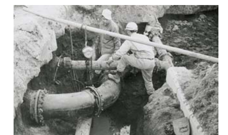
口径350mm配水管布設工事 (県道大分挾間線 昭和47年撮影)
