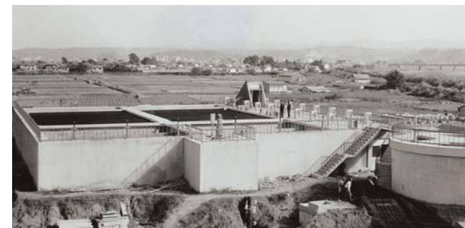
えのくま浄水場薬品沈澱池全景 (昭和43年9月撮影)
