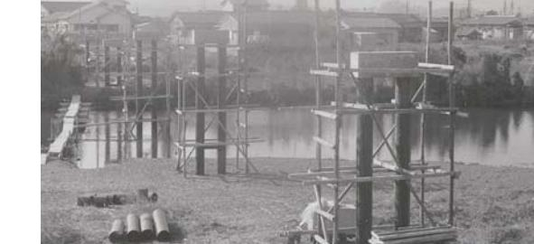
裏川水管橋(口径500mm鋼管添架)橋脚工事(昭和42年2月撮影)
