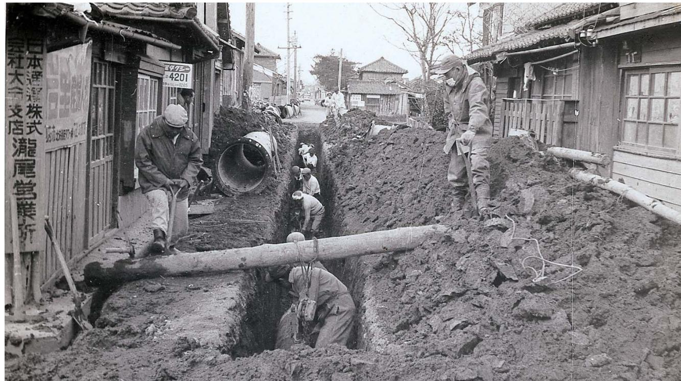
滝尾駅付近における口径700mm配水管布設工事(昭和39年2月撮影)
