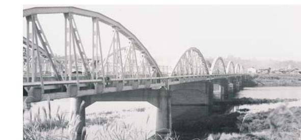
鋼管(口径200mm)添架工事の終了した乙津橋(昭和40年11月撮影)
