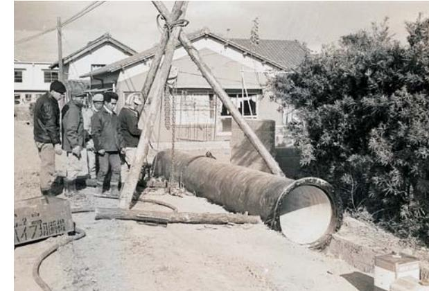
滝尾羽田地区における口径700mm配水管布設工事(昭和39年2月撮影)
