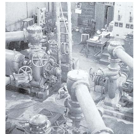
拡張工事を急ぐ畑中ポンプ場(昭和32年8月1日号 大分市報から)
