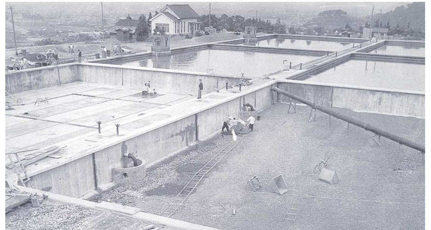
増設工事の三芳浄水場ろ過池
