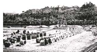
畑中取水場工事着手状況(大正14年)
