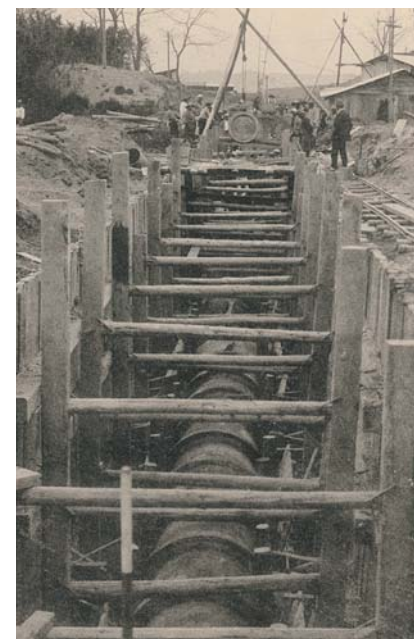
導水管布設の状況(大分市水道誌から)
