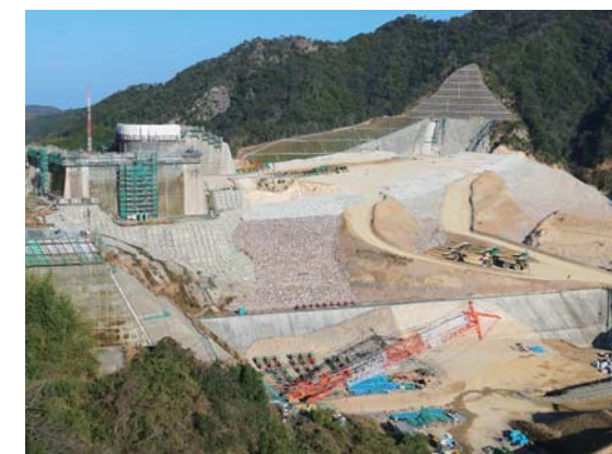
建設中の大分川ダム(平成28年)
