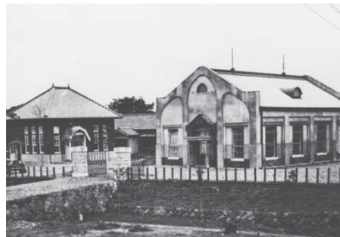
畑中ポンプ所(昭和2年)
