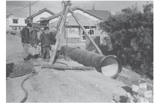
滝尾羽田地区口径700mm配水本管布設工事(昭和39年)
