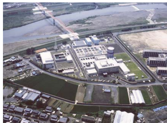
古国府浄水場(昭和63年)
