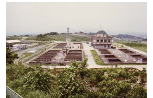
横尾浄水場(昭和50年)
