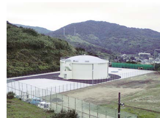
佐賀関配水池(平成21年)
