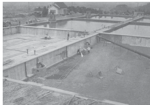
三芳浄水場ろ過池増設工事(昭和30年)
