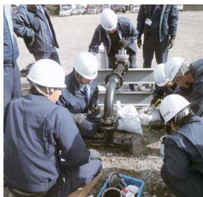
「技術の継承」実技研修
