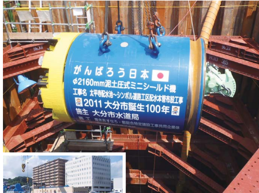
緊急時連絡管（水道管）整備事業 地中を掘削しながら配管を行うためのシールド機。災害時においてもより安定した給水が可能となるよう配水管網を整備しています。
