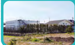
馬場ポンプ場
