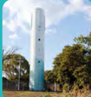
上野配水池・上野高架水槽
