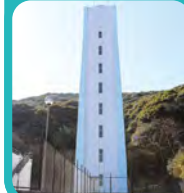
志生木ポンプ場・高架水槽
