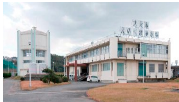
【えのくま浄水場】
