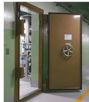
防水扉の設置
