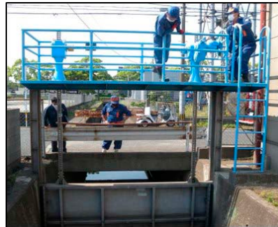
水門操作員(消防団)との合同点検
