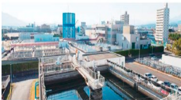
【古国府浄水場】
