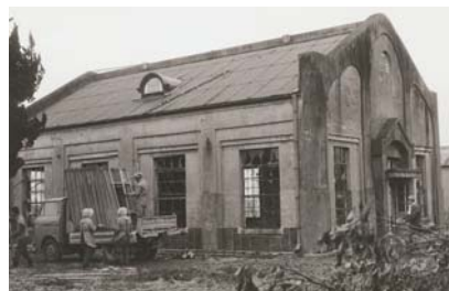
解体工事着手直前の畑中ポンプ場 (昭和46年2月撮影)
