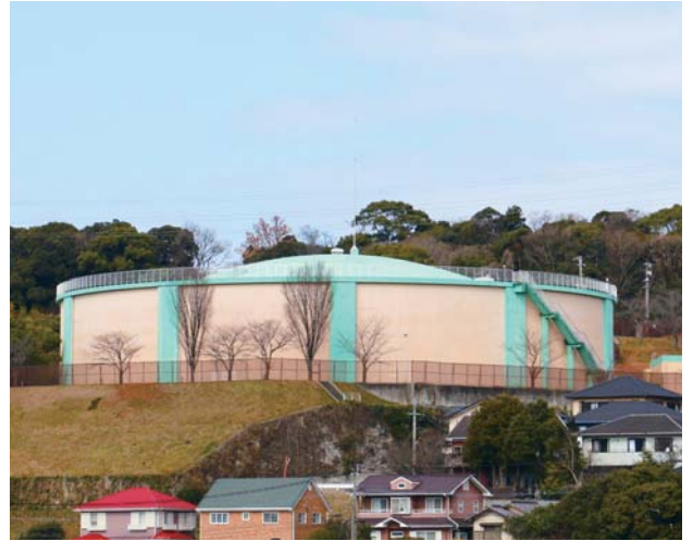
太平寺配水場(平成8年完成)
