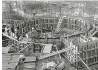
築造工事中の洗浄水槽 (昭和49年撮影)
