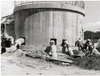
着水井まわり配管工事 (昭和43年撮影)
