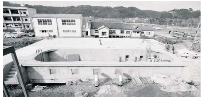
築造工事中の浄水池
