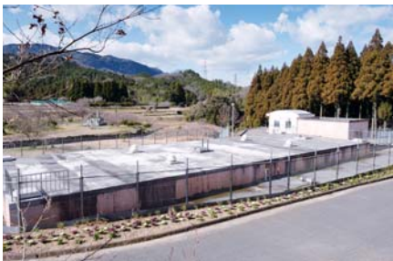
住床減圧水槽 (平成9年完成)
