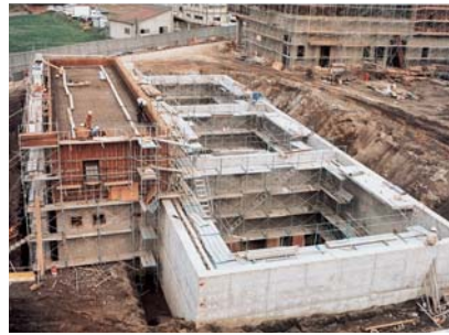
築造工事中の排水池
