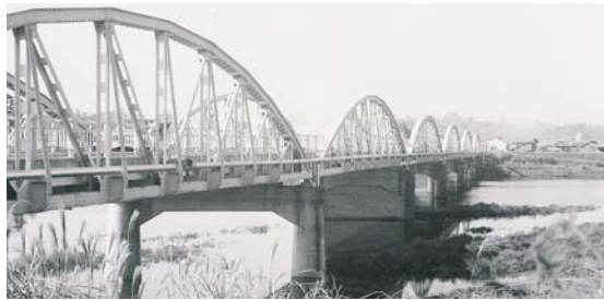
鋼管（口径200mm）添架工事の終了した乙津橋（昭和40年11月撮影）
