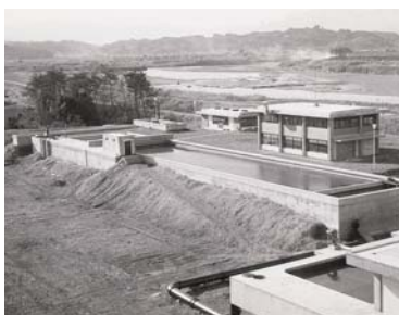
完成した薬品沈澱池・薬品倉庫 （昭和38年7月撮影）
