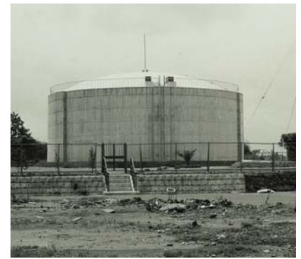
完成した明野配水池（昭和44年4月撮影）
