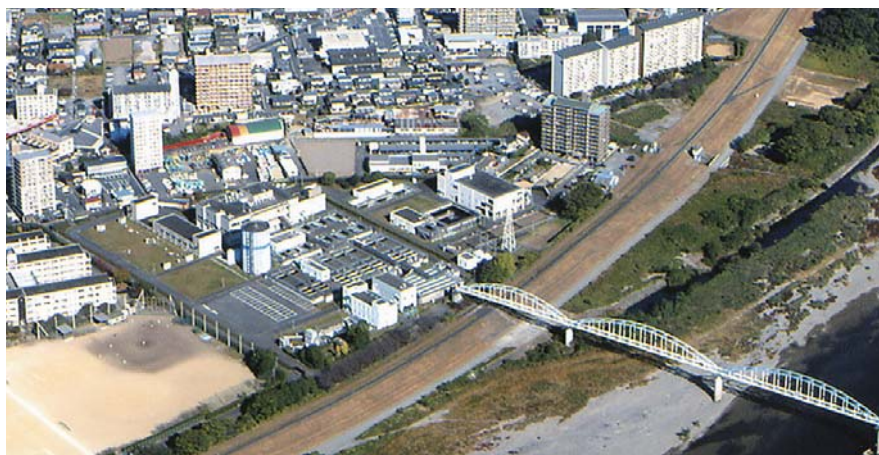
古国府浄水場と大分川水管橋
