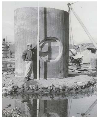
せつごうせい 畑中水源地接合井の修理工事 (昭和33年撮影)
