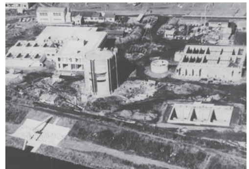
完成間近のえのくま浄水場(昭和44年)
