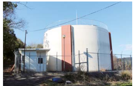
野津原東部配水池 (平成19年完成)
