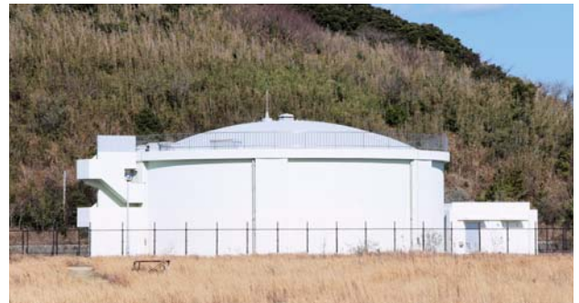
佐賀関配水池 (平成21年完成)
