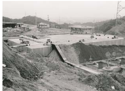
築造工事中の配水池 (昭和47年5月撮影)
