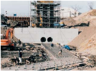
取水樋門築造工事（昭和63年2月撮影）
