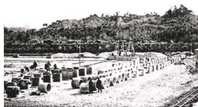
畑中取水場工事着手状況(大正14年)
