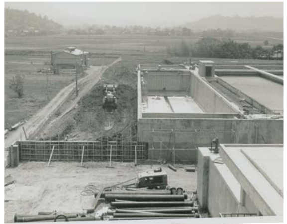
増設工事中の光吉浄水場薬品沈澱池（昭和42年撮影）
