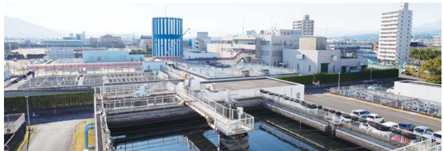
古国府浄水場全景（平成28年撮影）
