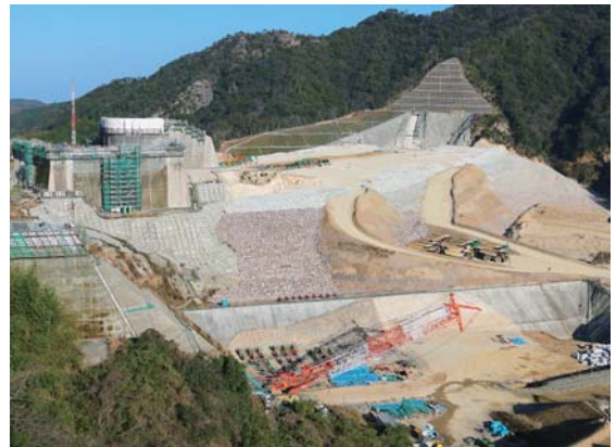
建設中の大分川ダム (平成28年)
