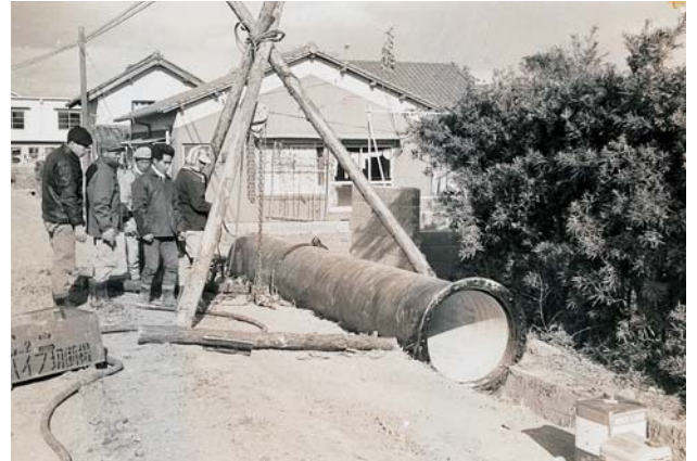
滝尾羽田地区における口径700mm配水本管布設工事(昭和39年2月撮影)
