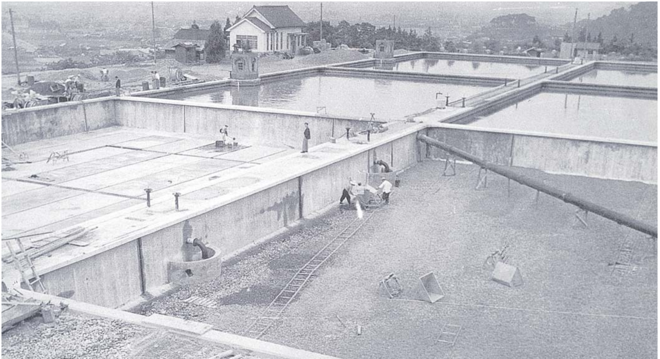
増設工事中の三芳浄水場ろ過池
