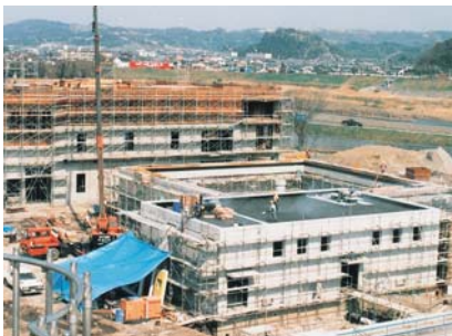
築造工事中の管理本部
