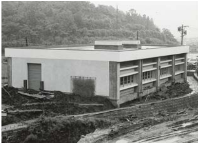
導水ポンプ室 (昭和47年6月撮影)
