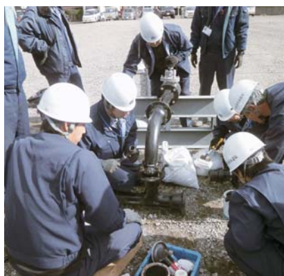
「技術の継承」実技研修
