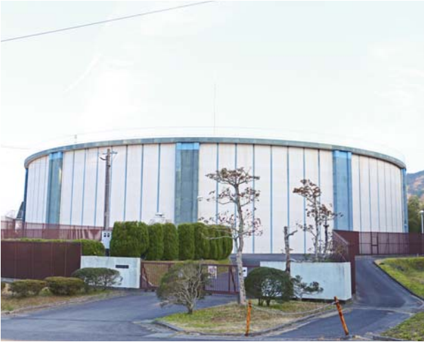
石川配水場(平成4年完成)
