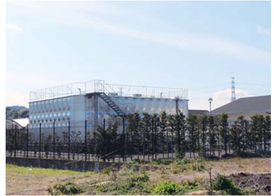
馬場ポンプ所 (平成23年完成)
