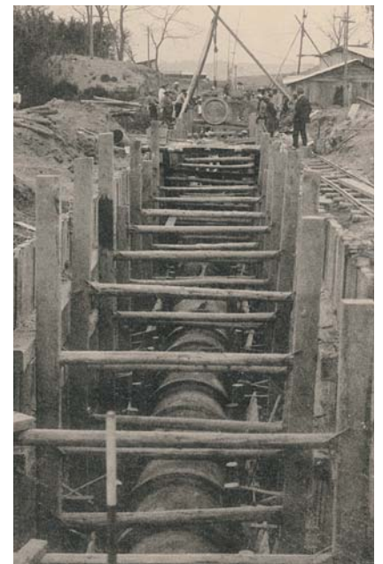
導水管布設の状況(大分市水道誌から)
