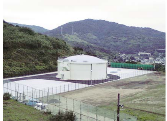
佐賀関配水池 (平成21年)
