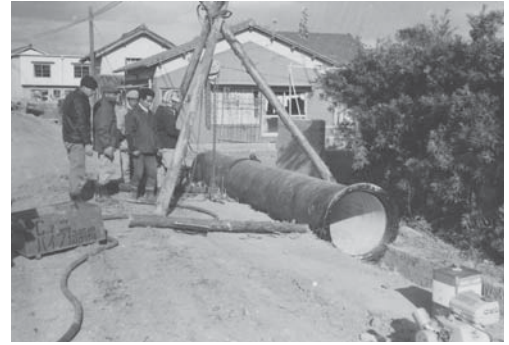
滝尾羽田地区口径700mm配水本管布設工事(昭和39年)
