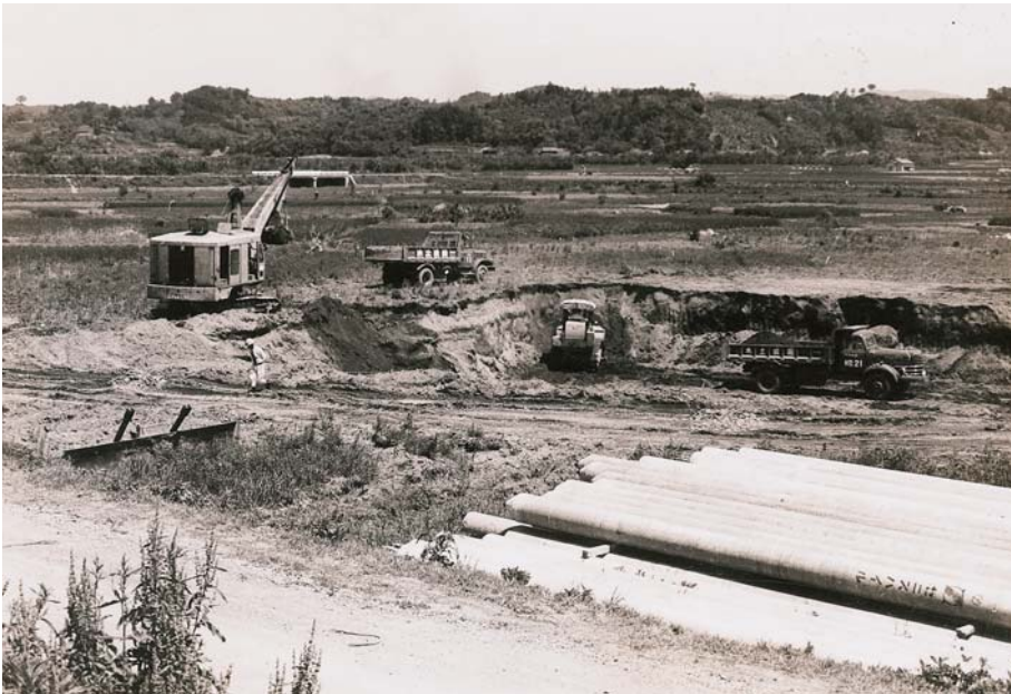
着工直後の光吉浄水場（昭和36年撮影）
