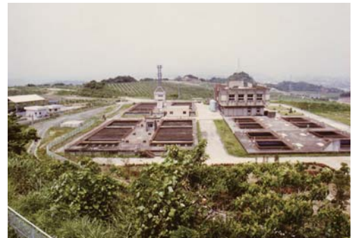
横尾浄水場(昭和50年)
