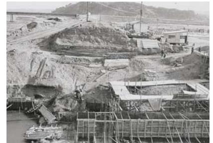
工事中の取水ポンプ井（昭和37年撮影）
