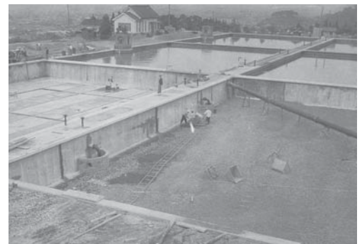
三芳浄水場ろ過池増設工事(昭和30年)
