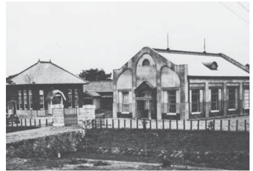
畑中ポンプ所(昭和2年)
