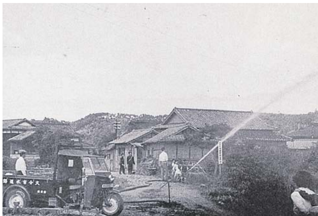
完成した北下郡配水管 (昭和29年4月2日撮影)
