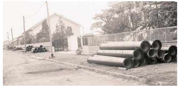
大分商業高校前の口径350mm配水管（昭和41年5月撮影）
