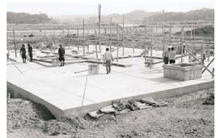
工事中の浄水池（昭和37年撮影）
