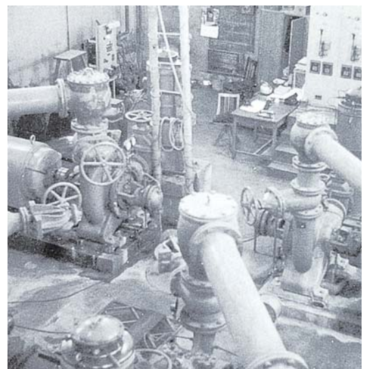
拡張工事を急ぐ畑中ポンプ場 (昭和32年8月1日号 大分市報から)
