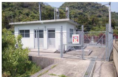
旧一尺屋浄水場
