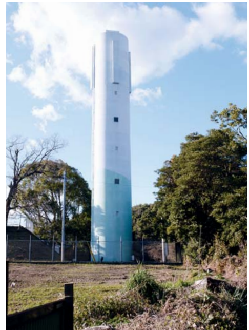
上野高架水槽(平成10年完成)
