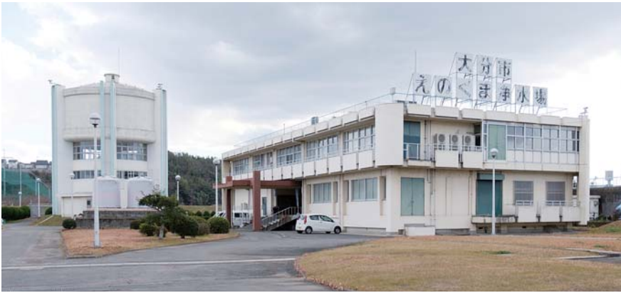
えのくま浄水場全景（平成28年撮影）
