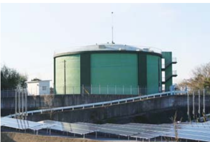
丹川配水池(平成6年完成)
