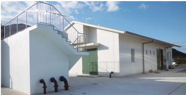
岩ノ下浄水場・膜ろ過施設 (平成25年完成)
