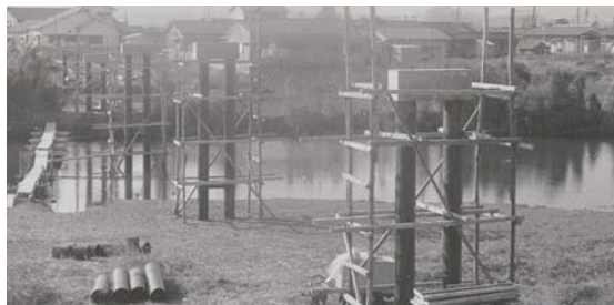
裏川水管橋（口径500mm鋼管添架）橋脚工事（昭和42年2月撮影）
