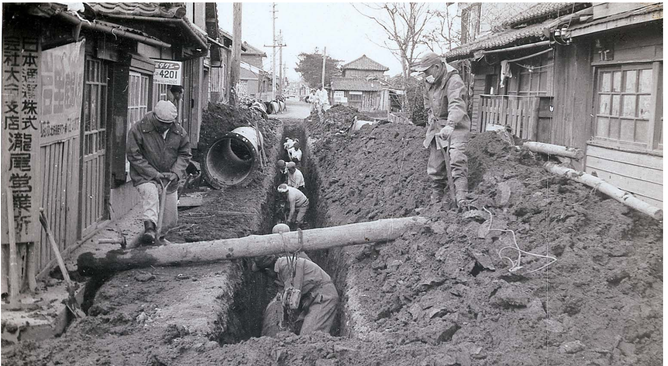
滝尾駅付近における口径700mm配水本管布設工事(昭和39年2月撮影)
