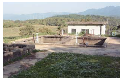
旧野津原西部第1浄水場
