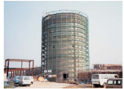
築造工事中の洗浄水槽
