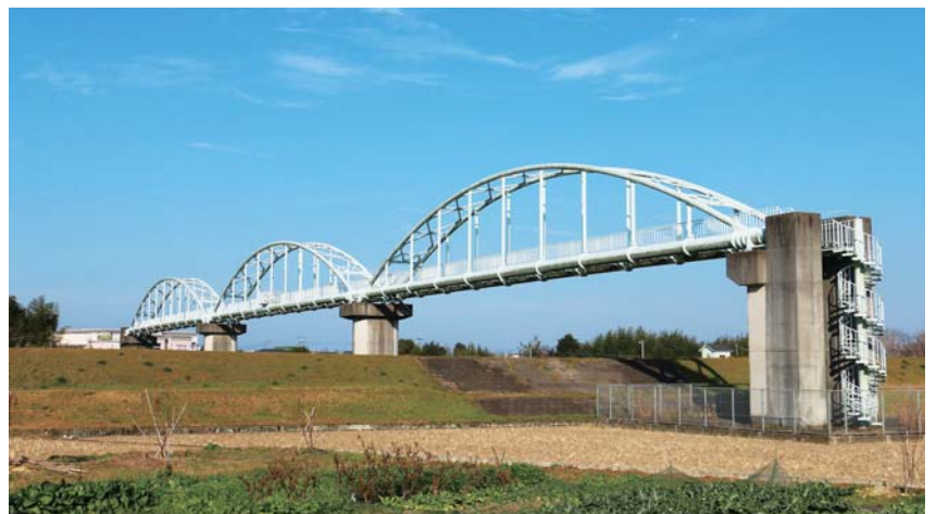
七瀬川水管橋(平成8年完成)
