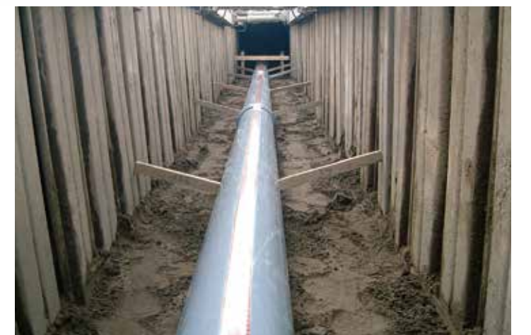
下水道管（汚水管）
