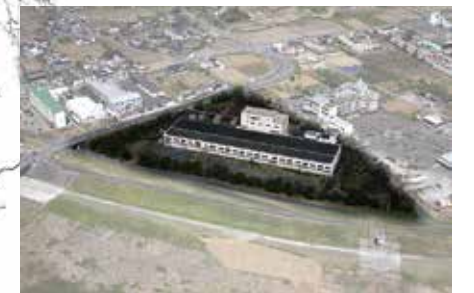
④ はるかみず しげんさいせい 原川水資源再生センター
