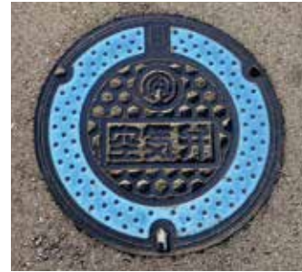
空気弁 (水道管の中の空気をぬく) べん かん
