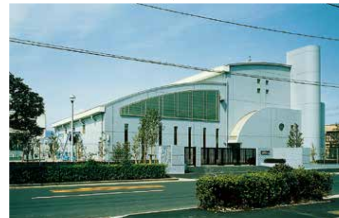
うすいはいすい 雨水排水ポンプ場
