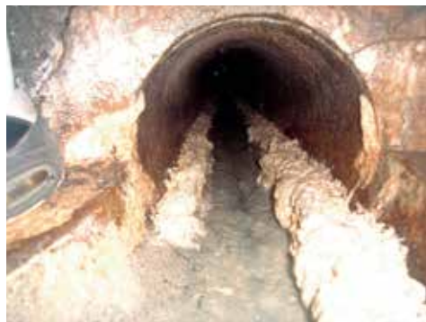
ラード（油）が付着した下水道管
