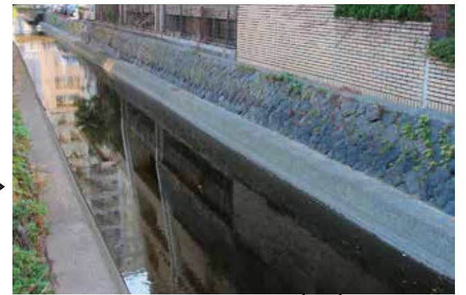
はいすいろ 排水路
