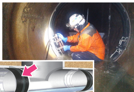
下水道管とマンホールなどの接続部分の耐震化
