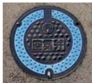
空気弁 (水道管の中の空気をぬく)
