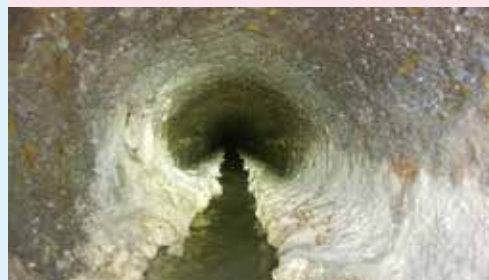
適切な維持管理ができずに油の固まった下水道管
