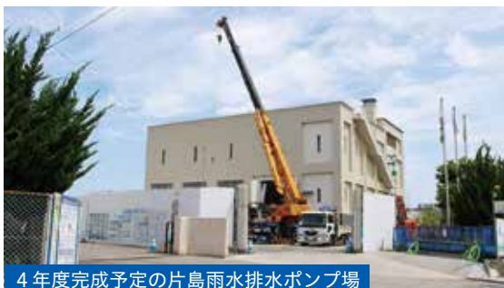
4年度完成予定の片島雨水排水ポンプ場
