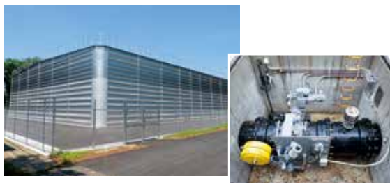
新しい森岡山配水池と緊急遮断弁
