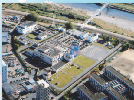
古国府浄水場
