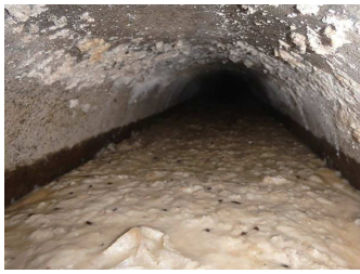
油脂類によって詰まっている下水道管
