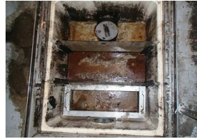
維持管理できていない状態
