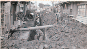
滝尾駅付近の配水本管布設工事（昭和39年）
