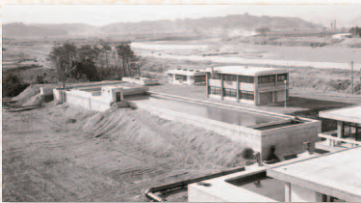
建設中の光吉浄水場（昭和38年）
