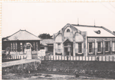
畑中ポンプ場全景（昭和2年）
