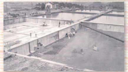
三芳浄水場拡張工事（昭和30年）
