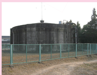
旧ふじが丘第1配水池用地
