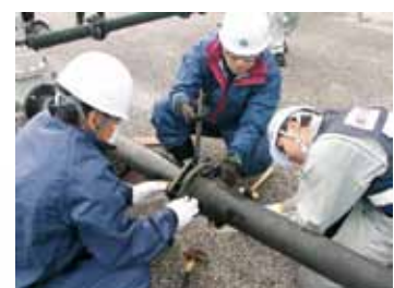
応急復旧訓練風景
