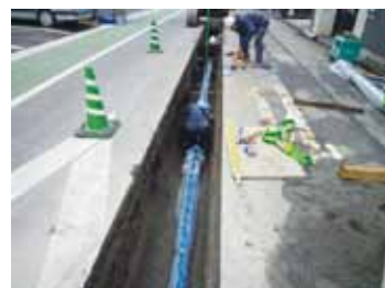
配水管耐震化工事風景
