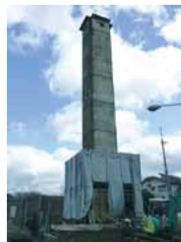
敷戸高架水槽耐震化工事風景
