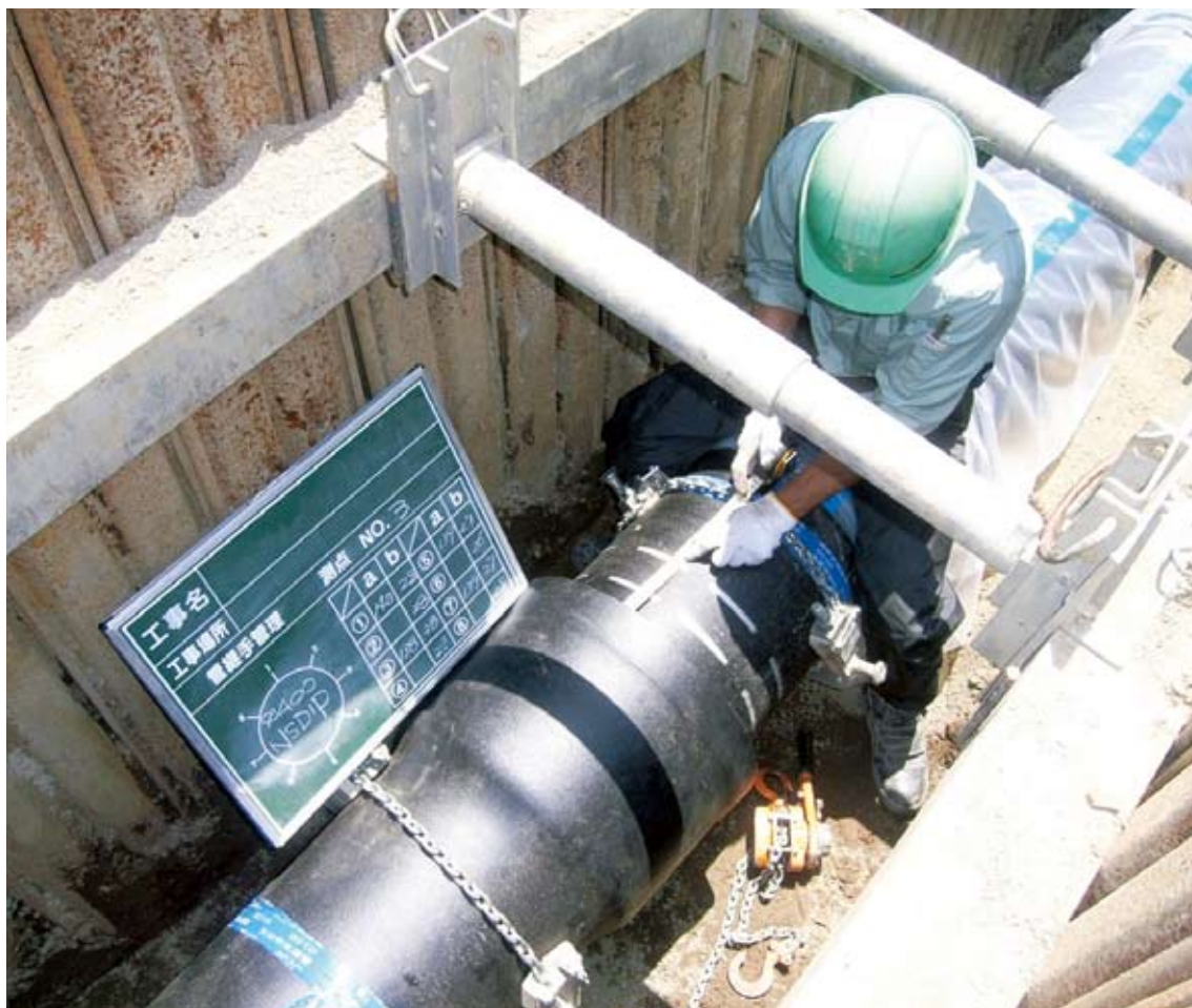
大分市水道局では、災害時でも市民の皆さまに安全・安心な水道水を安定的に供給できるように水道管の耐震化工事を進めています。
