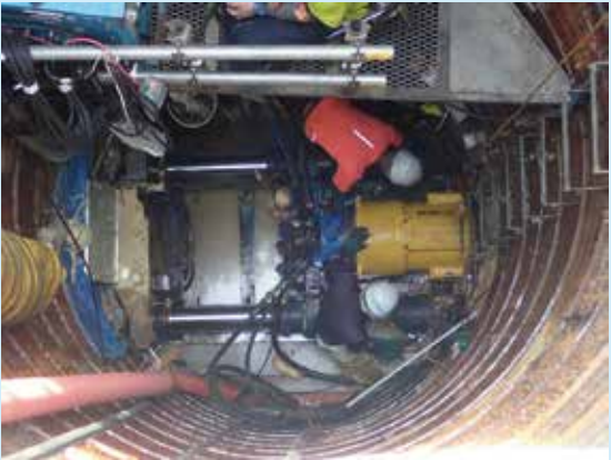
下水道管を入れるためのトンネル工事
