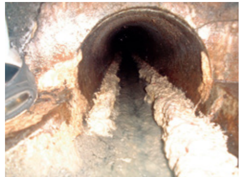
ラード（油）が付着した下水道管
