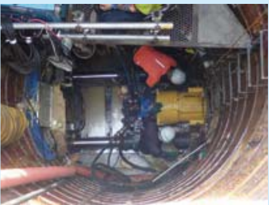
下水道管を入れるためのトンネル工事
