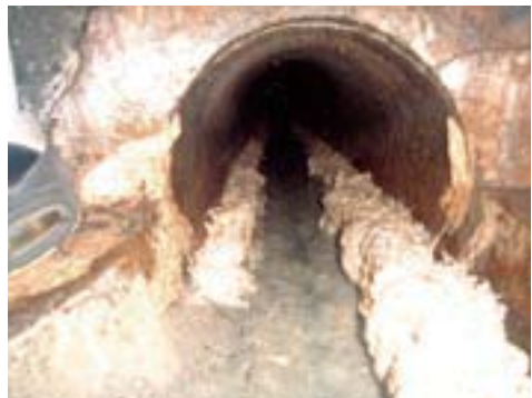
ラード（油）が付着した下水道管
