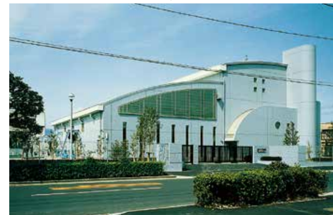
うすいはいすい 雨水排水ポンプ場
