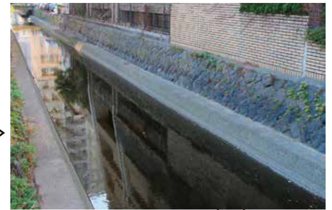
はいすいろ 排水路
