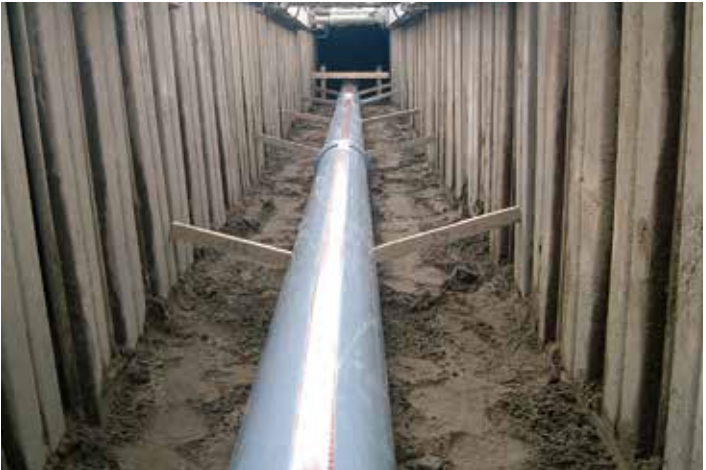
下水道管 (汚水)
