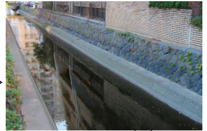
はいすいる 排水路
