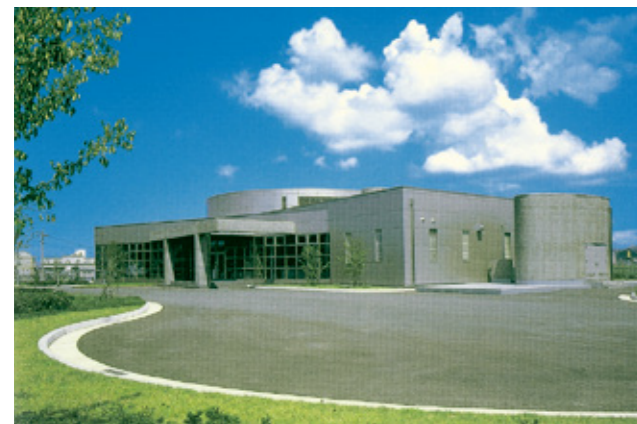
おすいちゅうけい 汚水中継ポンプ場
