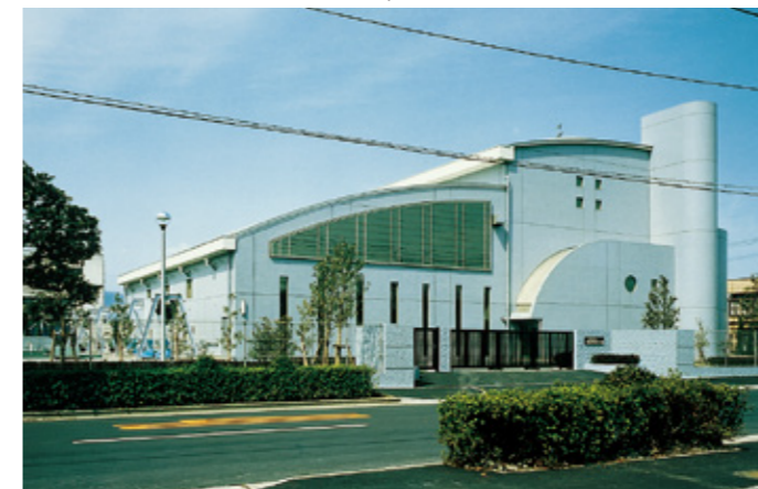
うすいはいすい 雨水排水ポンプ場
