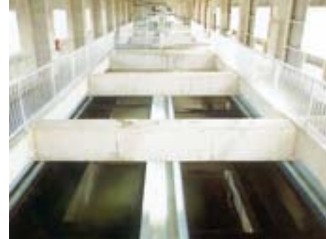
④最終ちんでん池
