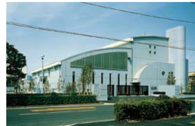
うすいはいすい 雨水排水ポンプ場
