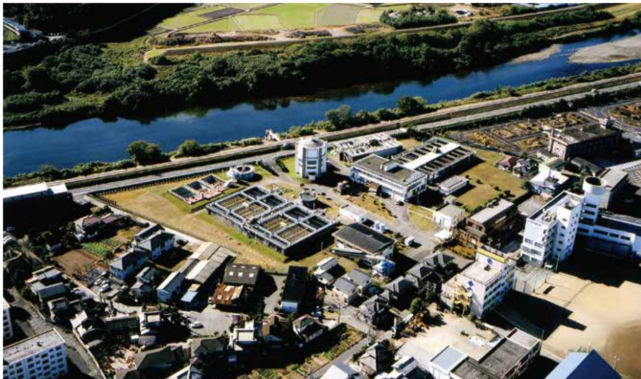
じょうすいじょう えのくま浄水場 (1日にプール (300㎡) 193はい分の) (58,000㎡) 水を作ることができます
