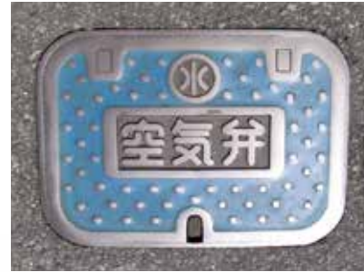
空気弁 (水道管の中の空気をぬく) べん かん
