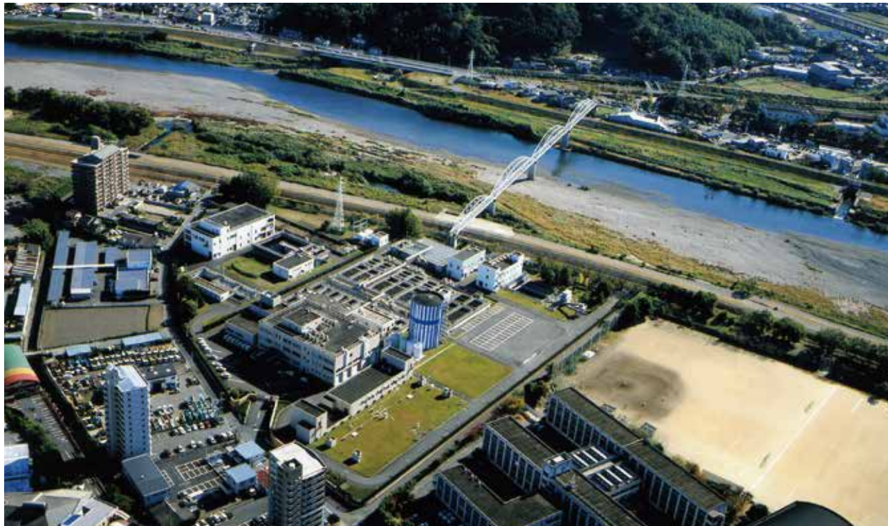
ふる こう じょうすいじょう 古国府浄水場 (1日にプール (300㎡) 283はい分の) (85,000㎡) 水を作ることができます
