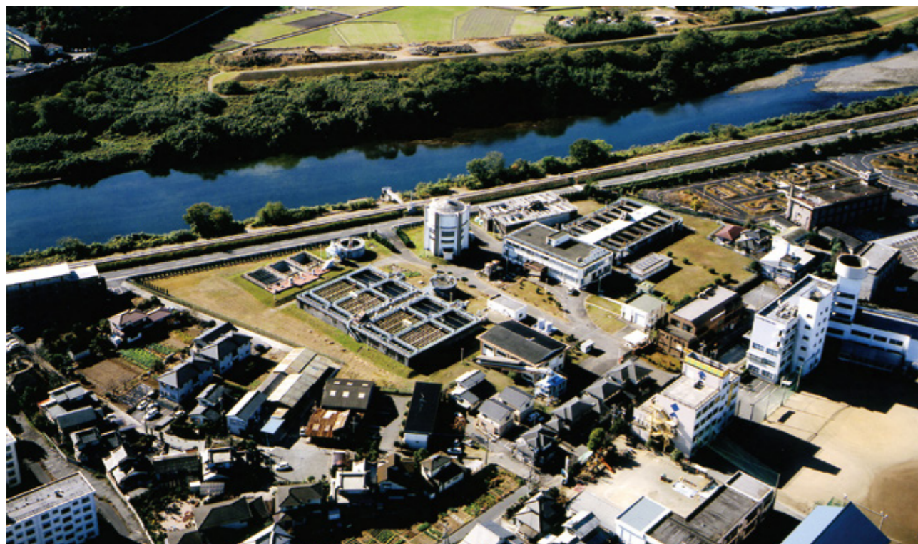
えのくまじょうすいじょう えのくま浄水場 (1日にプール (300㎡) 193はい分の) (58,000㎡) 水を作ることができます
