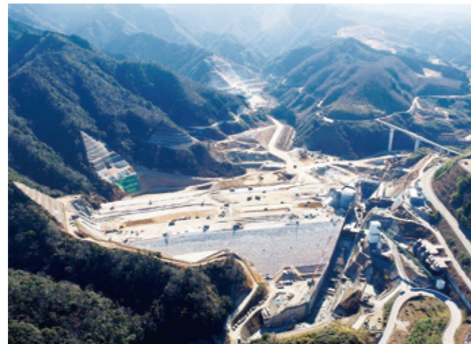
ななせダム建設工事
