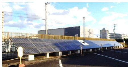
古国府浄水場の太陽光発電
