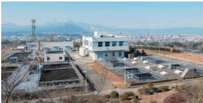
写真 横尾浄水場
