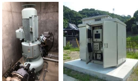
三芳配水場の小水力発電
