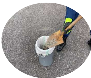
土のう袋を被せて 土砂を入れます。
