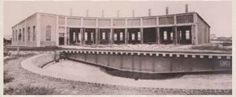
「竣工当初の大分駅機関庫(1912年)」『大分停車場構内扇形機関庫写真帖』大分市歴史資料館
