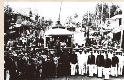
「町の中心に延長された電車軌道(1902年)」 大分交通株式会社
