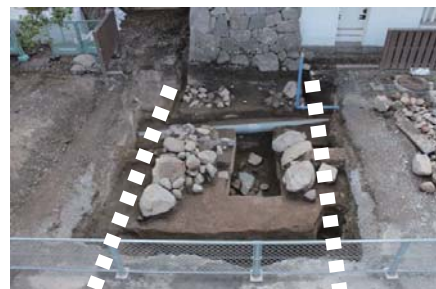
▲発見された石垣の根石と栗石（北より）
