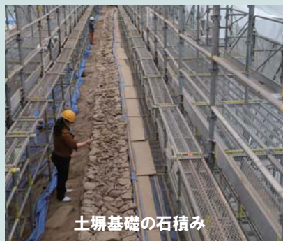
伝統工法でつくった土塀の試作品
