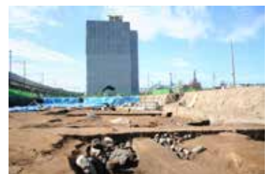
図42 2012年11月 大型マンション解体状況 大友氏館跡第28次調査地点から
