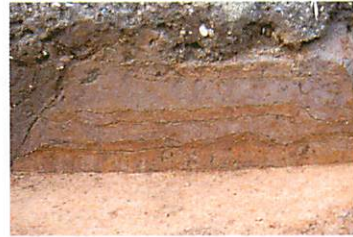
築地堀の基礎の跡
