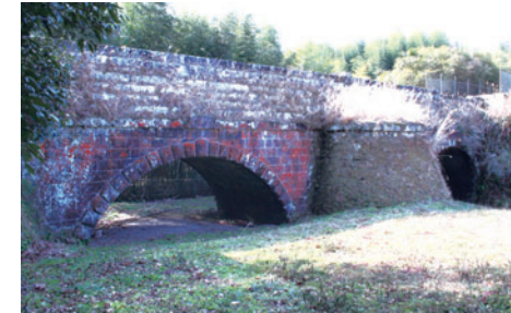
6 めいじ おおいたすいろ 明治大分水路 第 3 区水路橋
