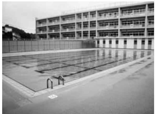
大在中学校プール（平成24年3月完成）
