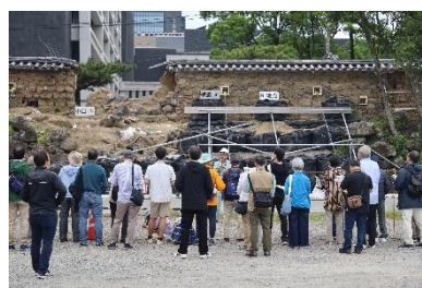
＜県指定史跡「府内城跡」西側土堀災害復旧工事現場見学会の様子＞
