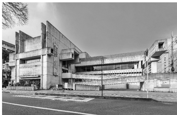
「旧大分県立大分図書館（アートプラザ）全景」
